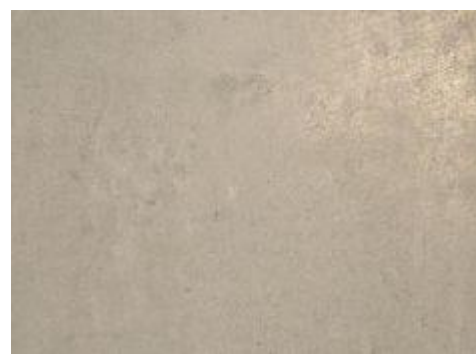
Apnena izravnalna masa, zglajena, pigmentirana, zaprta z milom za glajenje
